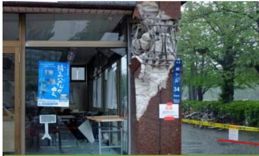
谷埋め盛土と地山の境界における建物の被害 (柱の座屈)
