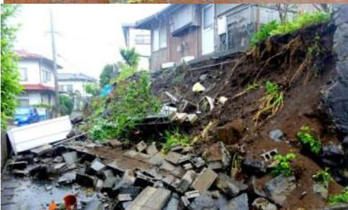
谷壁に張り付いた薄い盛土の崩壊
