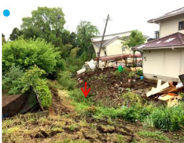
現在では水路となっている昔の道筋(矢印:凹んでいる所)とそれに向かって移動している小規模な地すべり。台地表層は、極めて軟弱な地盤で形成されている。
