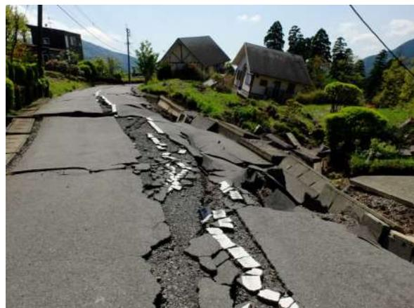
末端部の激しい地すべり変位。河岸部では、盛土による上載荷重の増加が被害を拡大した可能性がある
