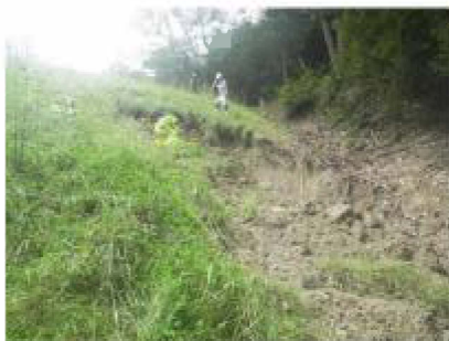
小池:取水施設側堤体下流より左岸側を望む
