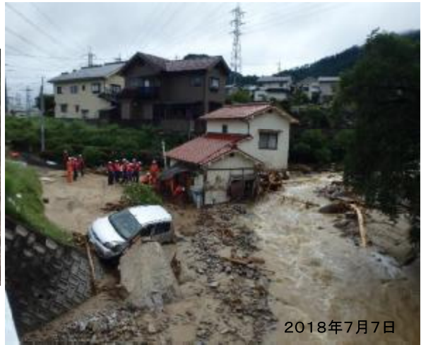
黒雲母花崗岩の巨レキが堰堤を破壊した土石流現場 源頭部は林道の崩壊地 広島市東区馬木 2018年7月11日
