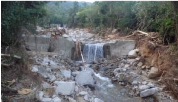
黒雲母花崗岩の巨レキが堰堤を破壊した土石流現場 源頭部は林道の崩壊地 広島市東区馬木 2018年7月11日
