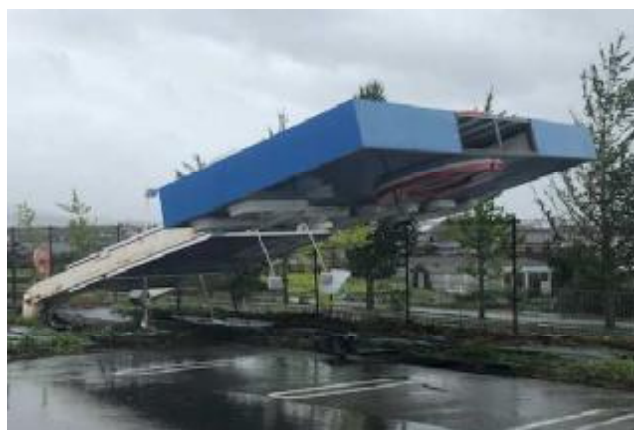
大型広告板の倒壊 大阪府貝塚市 (日本建築総合試験所 前田氏撮影)
