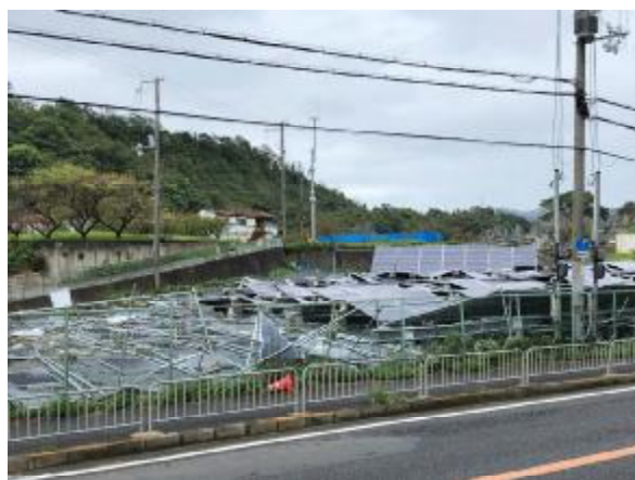
太陽光発電設備の被害 大阪府 (摂南大池内研究室提供)
