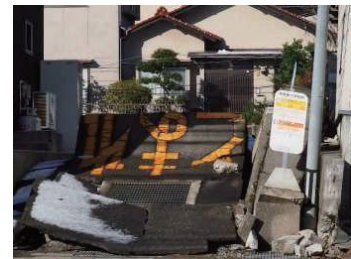
側方流動の影響で圧縮され浮き上がった舗装面
