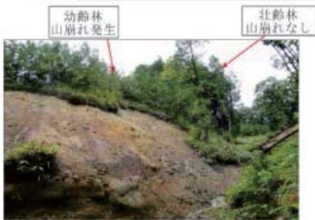
広島県庄原市で発生した山崩れの状況
