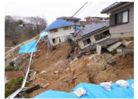
写真2 谷埋め盛土地すべり末端部の崩壊（2011年3月、福島市）
