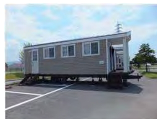
写真1 熊本県益城町の福祉避難所(2016年8月)
