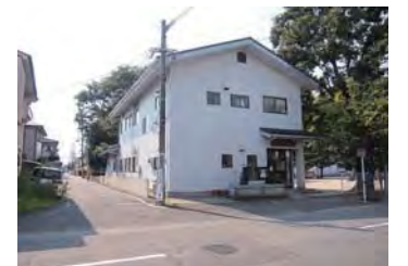
公園内にある集会所施設の例 （泉ヶ丘校区公民館）
