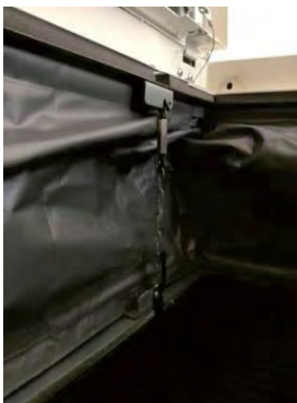
②内部吊り金具の破損
