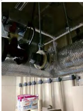
①バルブ附近での破断
