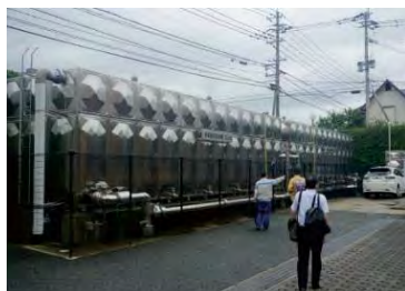
⑤受水槽外部設置（給水車対応）
