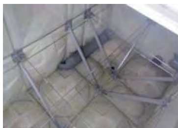
④水槽内部配管破損
