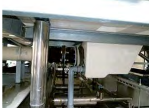
④屋上冷却水配管が移動
