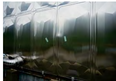
⑤受水槽外部設置（給水車対応）
