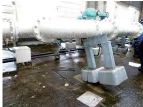
④屋上冷却水配管が移動
