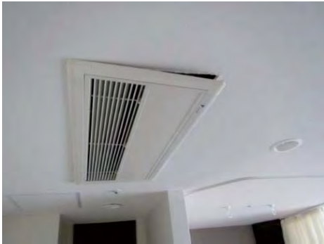
②内部吊り金具の破損
