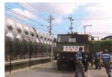
⑤受水槽外部設置（給水車対応）
