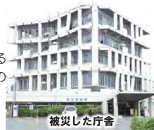
非構造部材の破損により利用できなくなった庁舎
