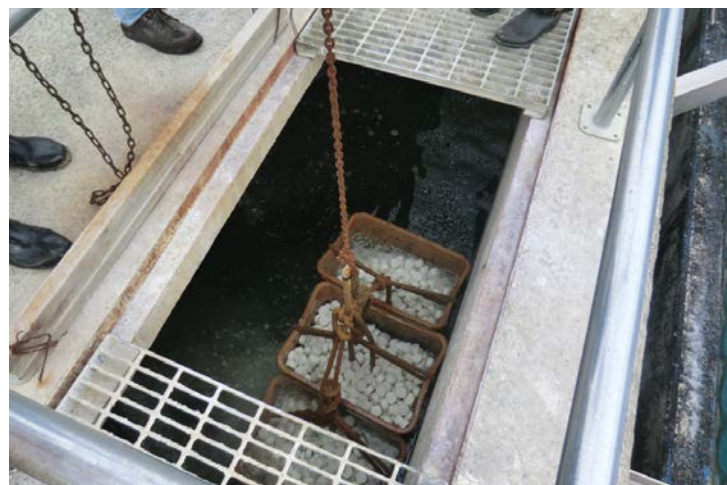
石巻 固形塩素による下水の消毒
