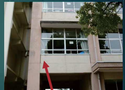
構造スリット 靱性補強
