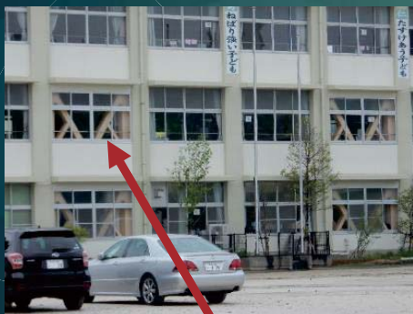
ブレース 強度補強
