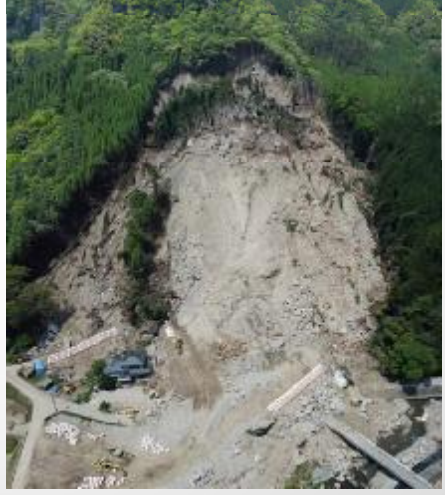
2018年4月中津市耶馬溪斜面災害
