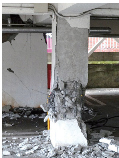
柱部材の損傷
