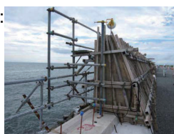
<既存護岸の嵩上げ>
